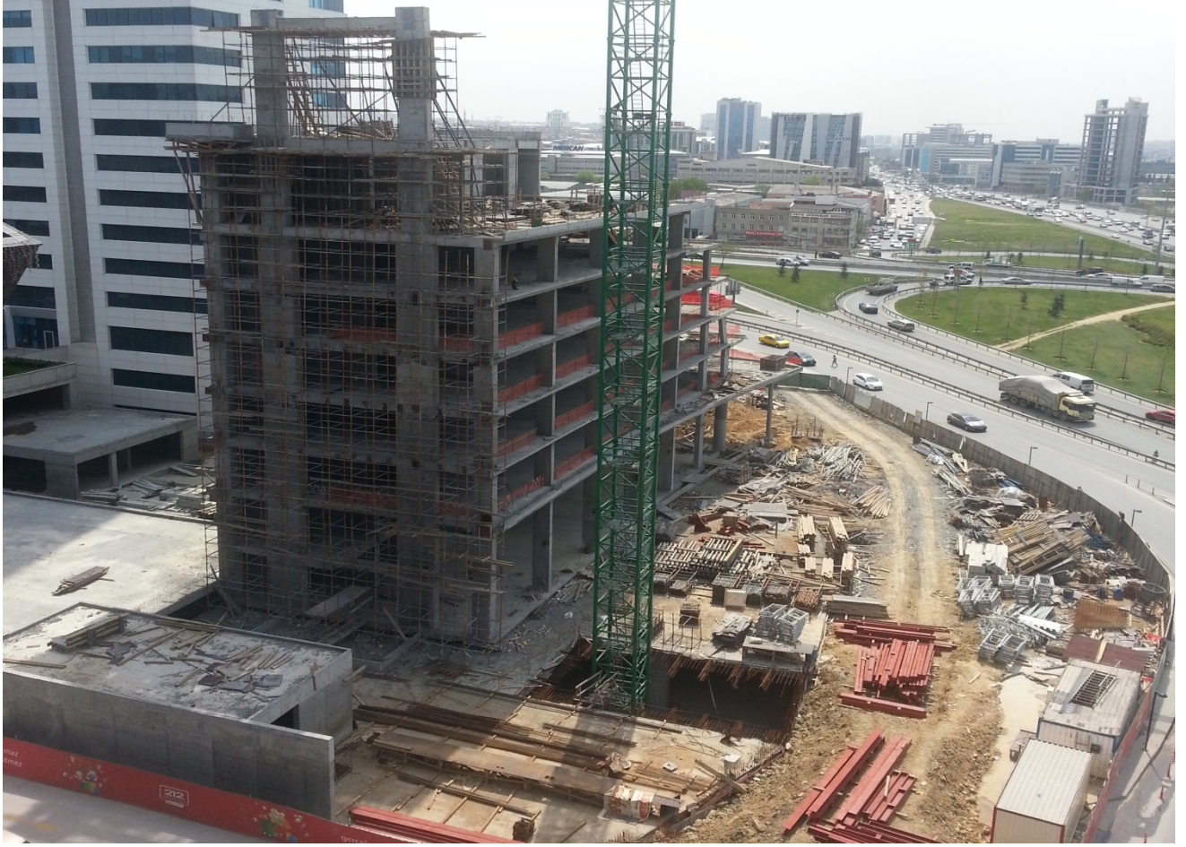
Otel inşaatı ilerleme durumu (Mayıs 2013)
