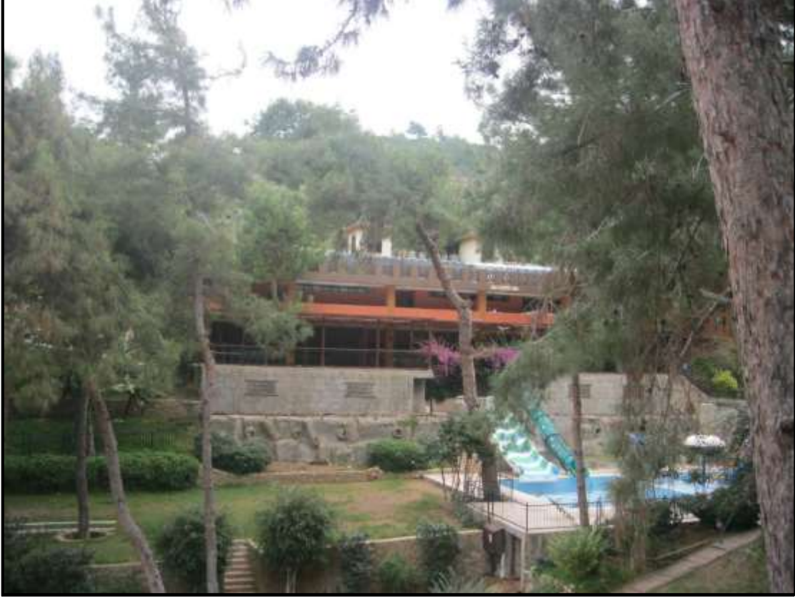
Bu ünite Aqua park kısmına hizmet amaçlı inşa edilmiştir.
