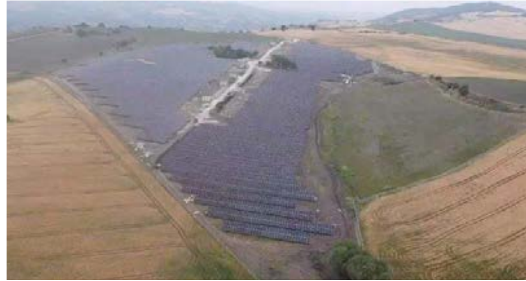
İsbir Susurluk GES Elektrik Santrali
