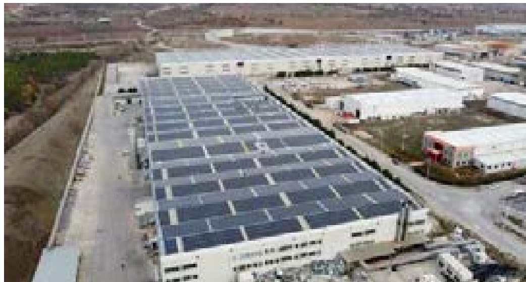
Balıkesir Fabrikası Çatı GES Uygulaması
