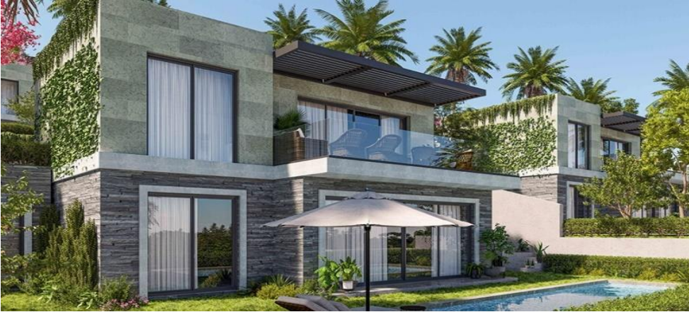
Fuga Panorama | Gümüşlük – Bodrum
