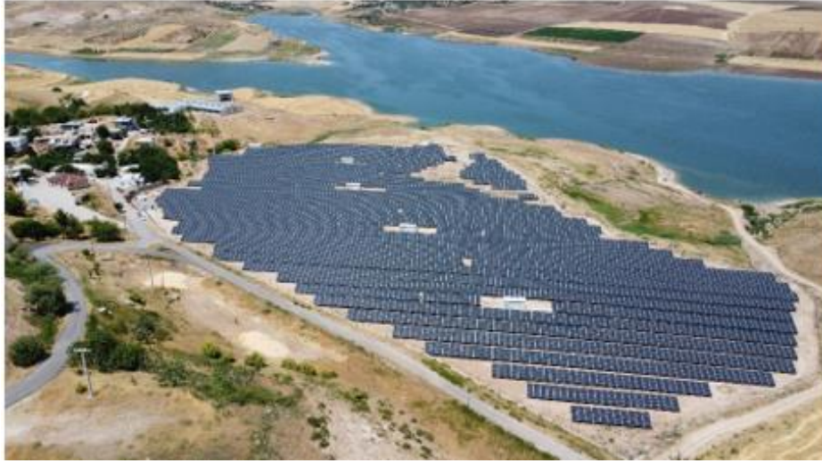
Adıyaman'da bulunan Denk, Yaka, Maya, Kelam GES lerin Havadan Çekilmiş Görüntüsü
