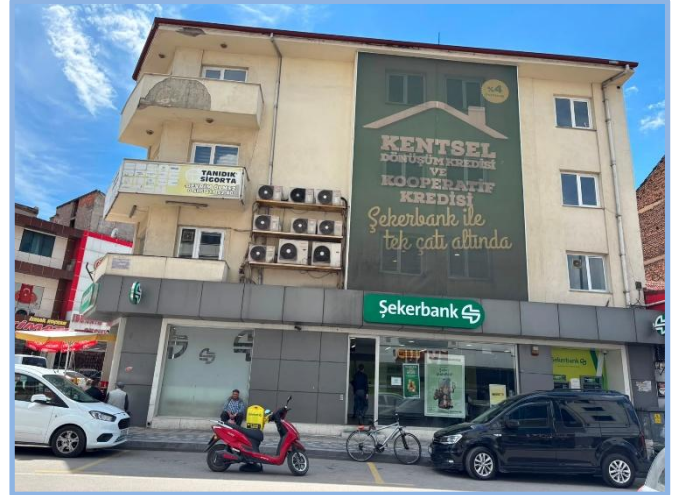
Bina (lojman katları) Girişi ve Cephe Görünümü
