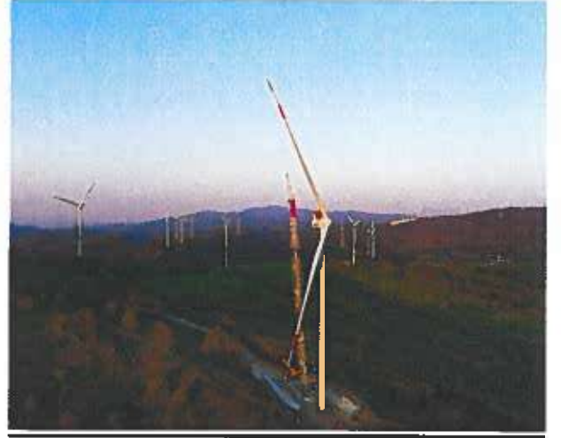
BALIKESİR ŞANLI RÜZGAR ENERJİ SANTRALİ
