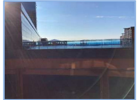
A2 Blok C305 No'lu Daire
