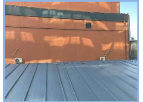
A2 Blok C107 No'lu Daire
