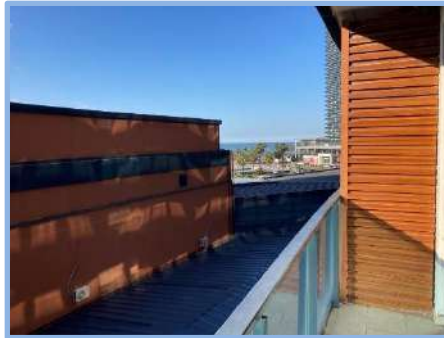
A2 Blok C305 No'lu Daire
