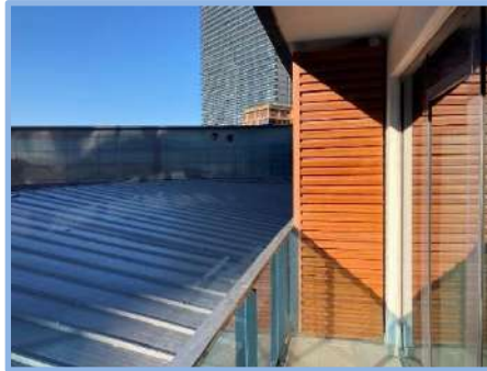
A2 Blok C107 No'lu Daire
