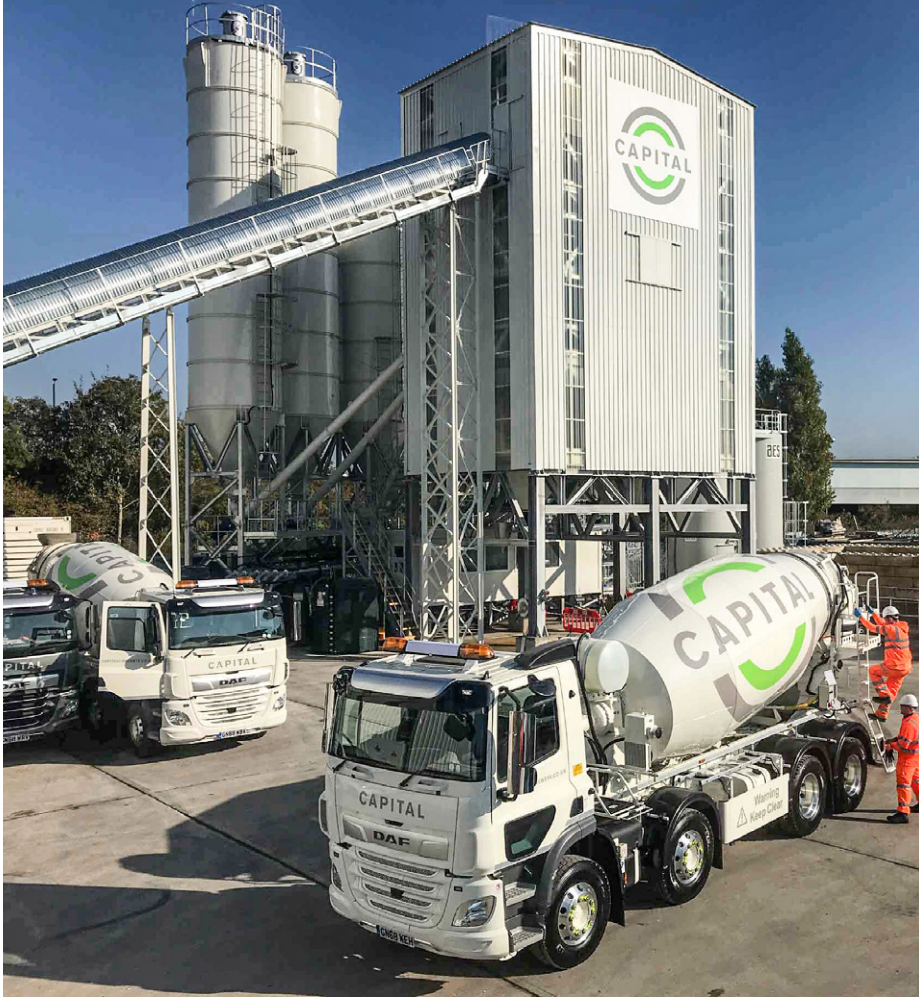
▲ MEKA Sabit Beton Santrali İngiltere
