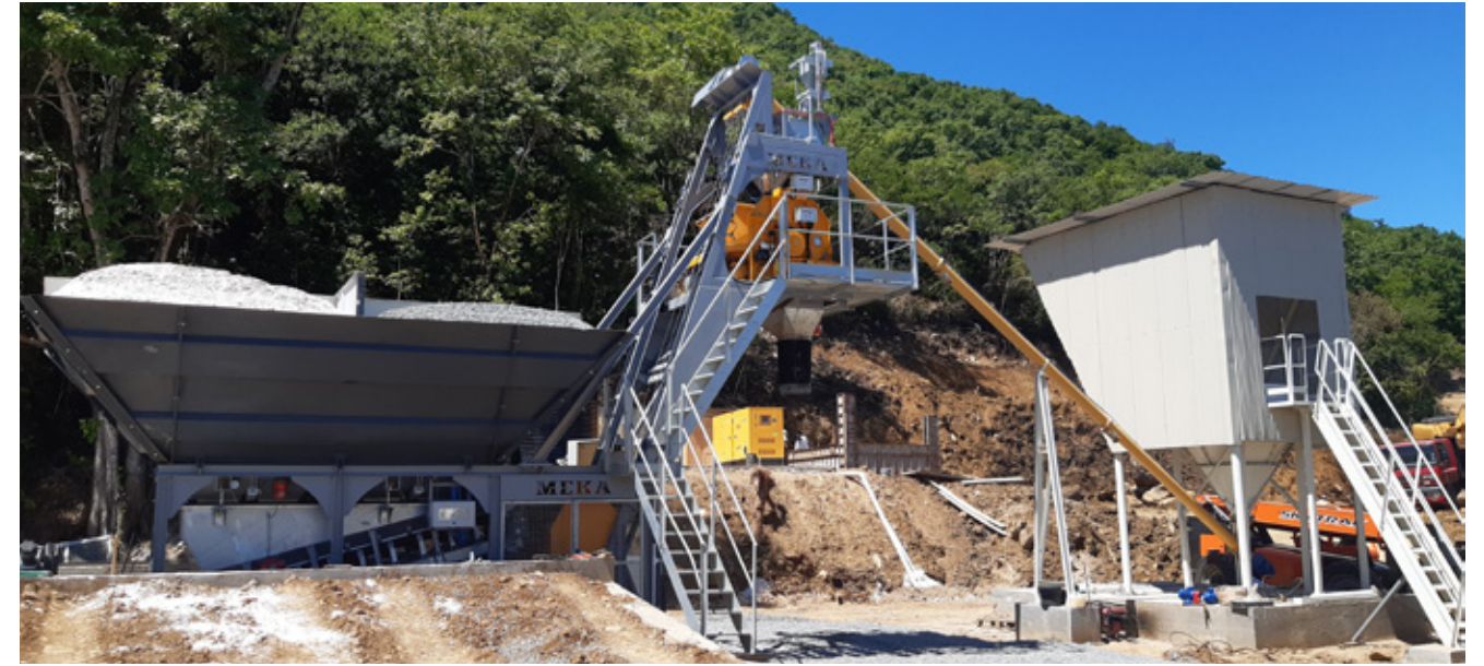
▲ Meka Kompakt Beton Santrali Kurulumu-2024 Karayip Adaları
