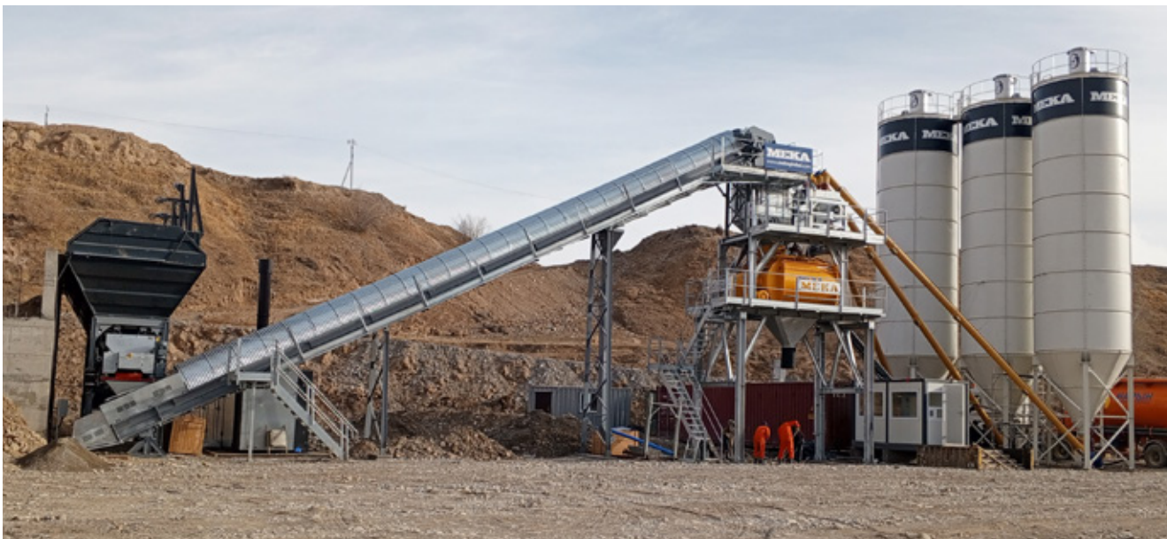
▲ Meka Sabit Beton Santrali Kurulumu-2024 Kırgızistan
