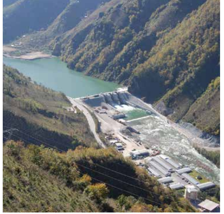
Aslancık Hidroelektrik Santrali, Giresun
