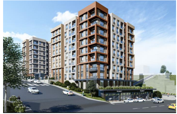
KARPEM İNŞAAT- ÜMRANİYE KORU PROJESİ
