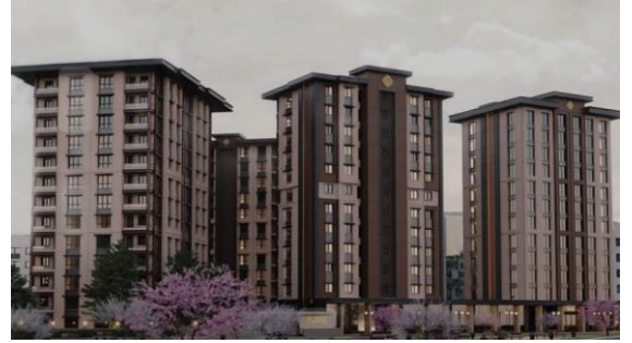
MİSEK İNŞAAT – KONUT PROJESİ
