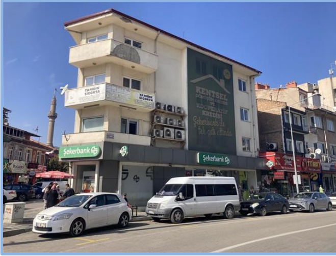
Cephe ve Çevre Görünüm
