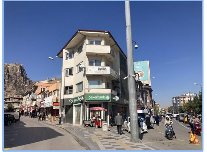
Cephe ve Çevre Görünüm
