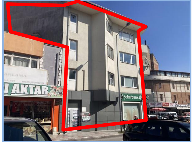
Bina (lojman katları) Girişi ve Cephe Görünümü
