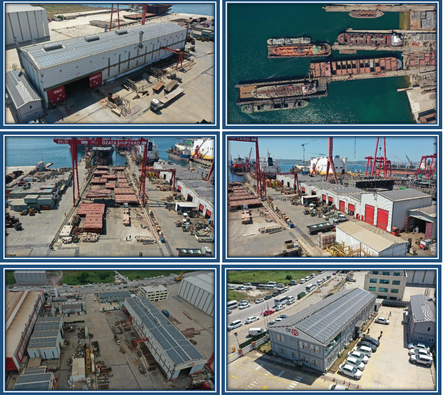
Şekil 2. Farklı Açılardan Tersane Saha Görünümü
