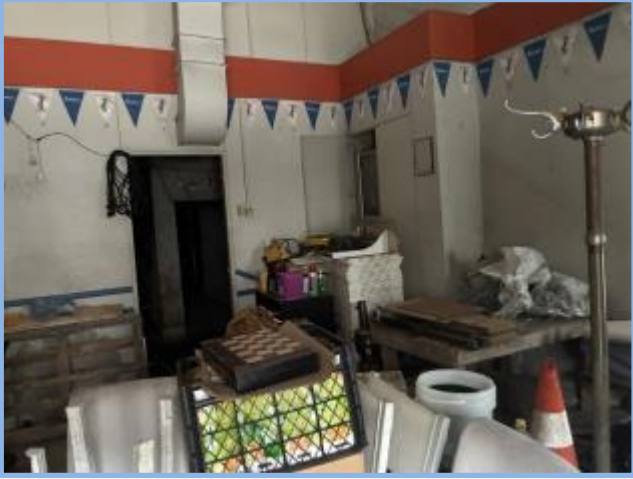
Zemin Kat Görünüm
