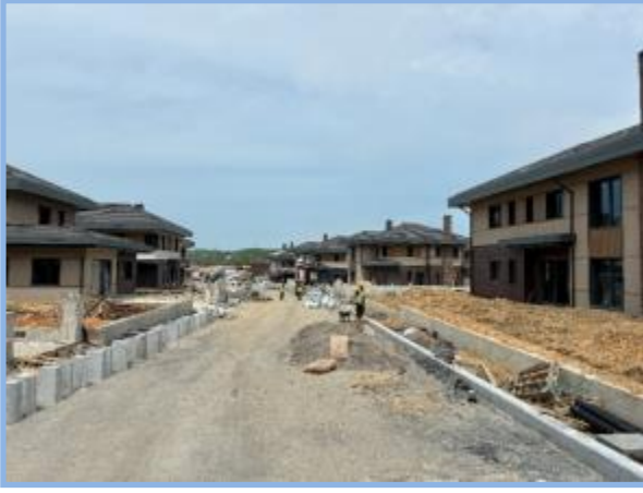
1. Etap Genel Görünüm
