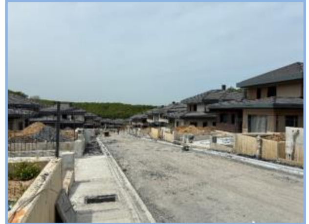
1. Etap Genel Görünüm
