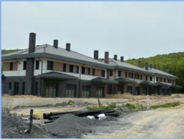
1. Etap Genel Görünüm
