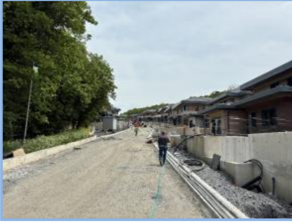
1. Etap Genel Görünüm
