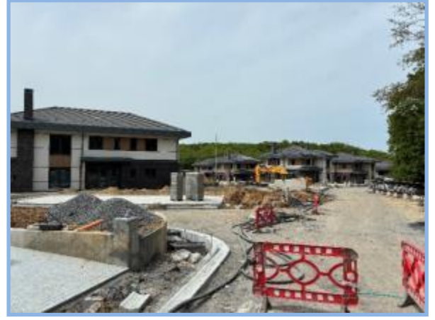
1. Etap Genel Görünüm
