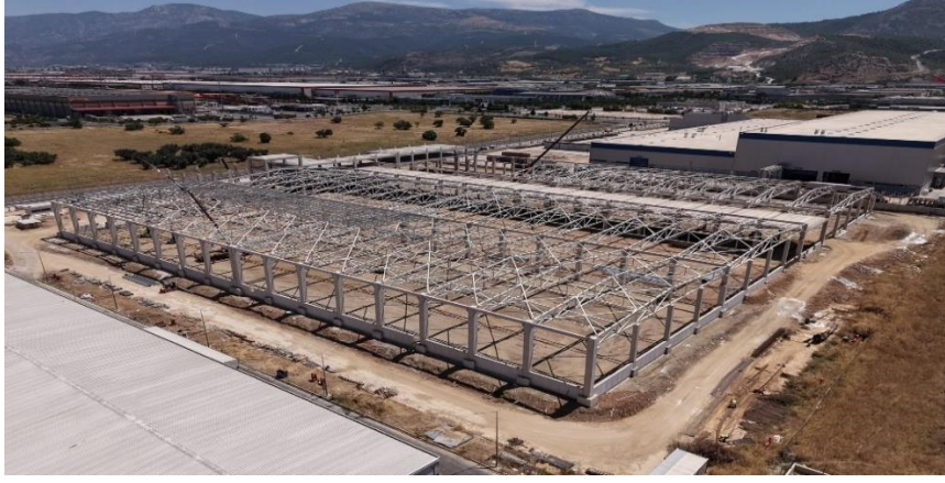
İnşaata Devam Eden Manisa Ambalaj Tesisi 2 Binası
