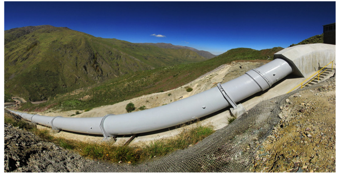
Çukurçay HES Cebri Boru Hattı
