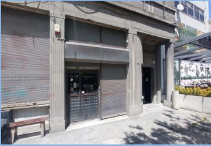
Zemin Kat Görünüm
