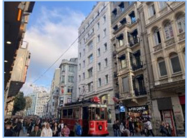
Değerlemeye Konu Bina (İstiklal Cd. Cephesi)
