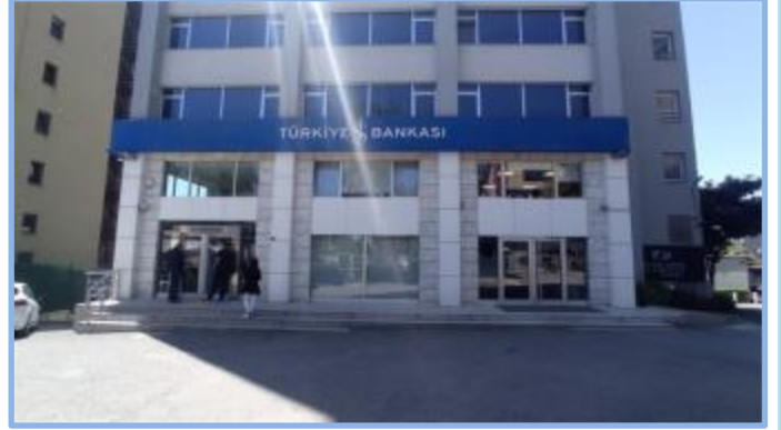
B Blok Görünümü (Tapu Kaydında C Blok)
