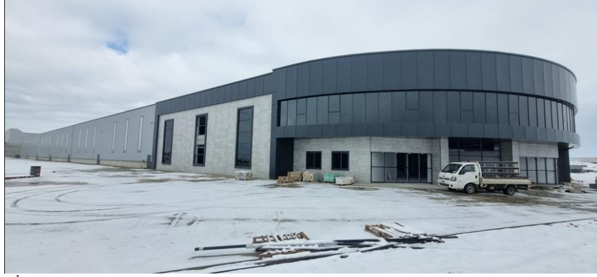
İnşaatı tamamlanan Eskişehir Fabrika Binası – Yatırım Amaçlı Gayrimenkul
