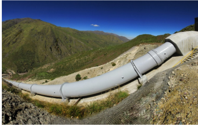
Çukurçay HES Cebri Boru Hattı
