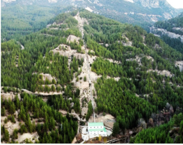
427 m 2 brüt düşü ve 1.20 m 3 /s proje debisine sahip Çukurçay Hidroelektrik Santralimiz
