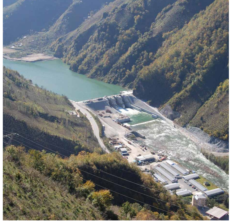
Aslancık Hidroelektrik Santrali, Giresun
