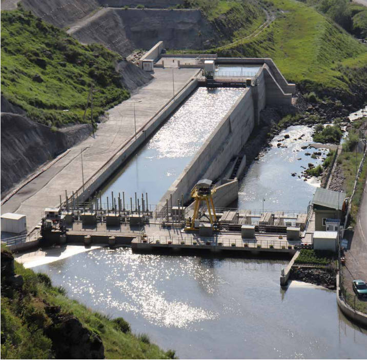
Paravani Hidroelektrik Santrali, Gürcistan
