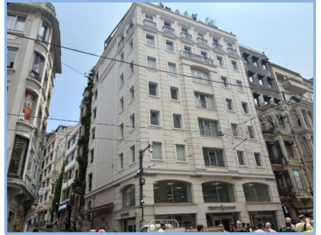
Değerlemeye Konu Bina (İstiklal Cd. Cephesi)
