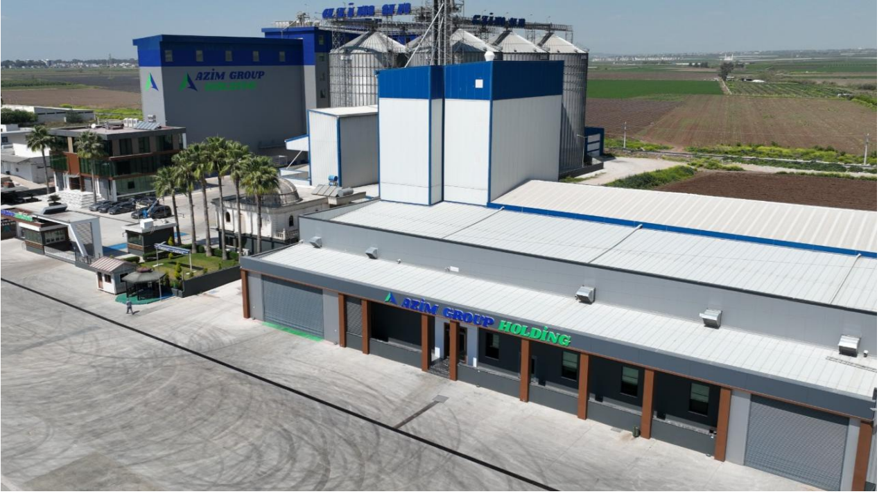
Akhan Un - Adana Fabrikası
